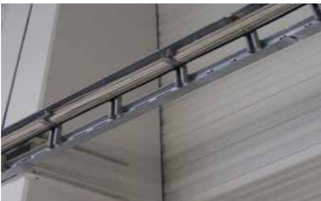
Sendvič paneli tretirani BioRid-om u skladišnoj zgradi
